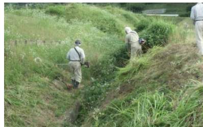
【排水路の草刈り】
