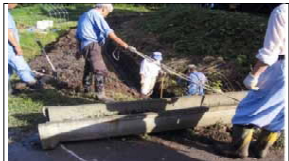
水路改修作業
