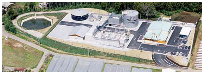
○日田市バイオマス資源化センター
