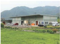
この4月に稼働を開始したバジル工場。食品会社に卸す前の一次加工を行っている
