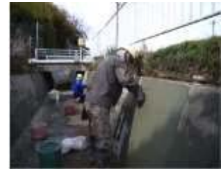
地域住民が作業員として参加し、直営で施工
