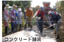
コンクリート舗装
