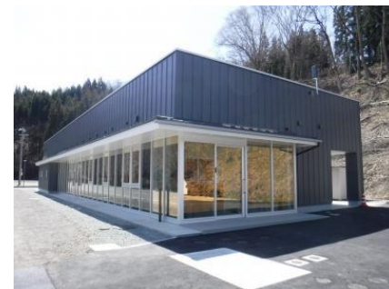
<長野市ジビエ加工センター>
