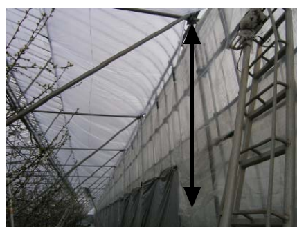
ハウス側面の二重被覆
