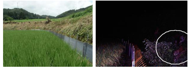
ワイヤメッシュ+トタン板実証ほ イノシシ侵入防止の様子
