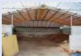
有機物供給施設
