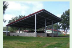
堆肥舎の設置
