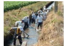
水路の泥上げ
