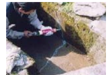
水路のひび割れ補修
