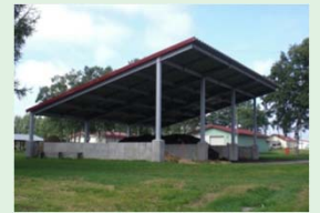
堆肥舎の設置
