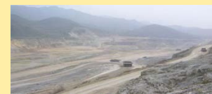
りん鉱石採掘現場
