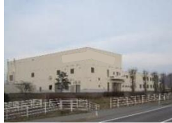
米粉製粉工場
