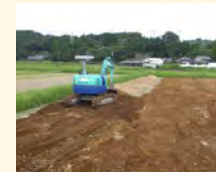
土層改良（客土）
