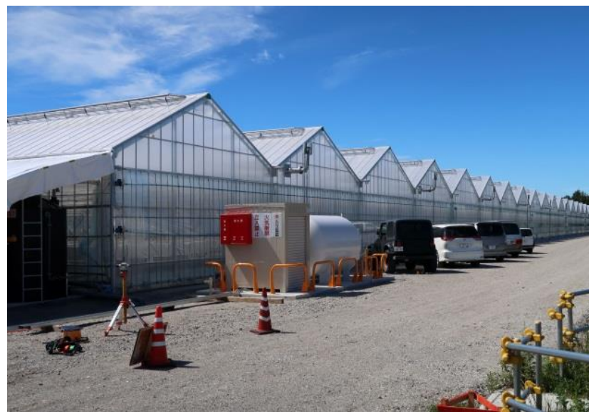
温室工事の様子(8月29日)
