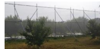
防風ネットの設置
