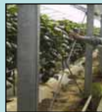
ブレースの増設
