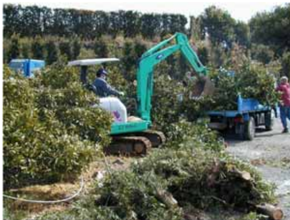
園内道設置作業
