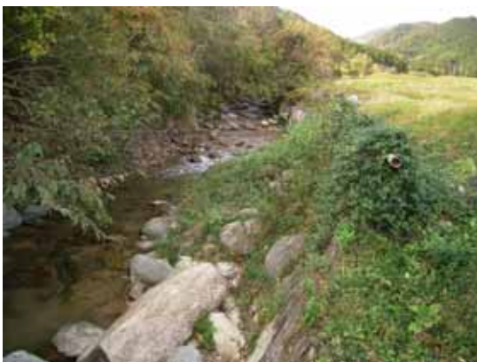
ワイヤーメッシュ（草で覆われている）の設置箇所（川岸に岩が堆積しイノシシが侵入可能）
