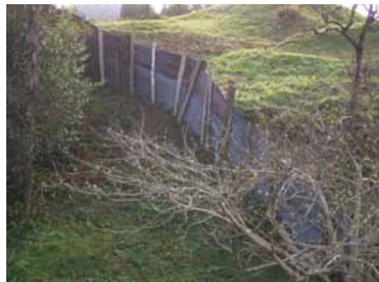
トタン板をイノシシ用防護柵 （傾斜地はトタン2段に組む）
