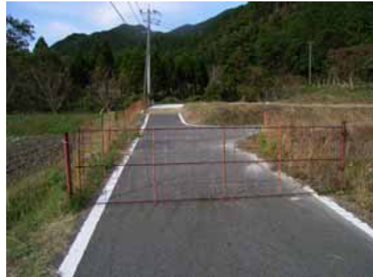
農道部分との交差箇所に設けられたゲート
