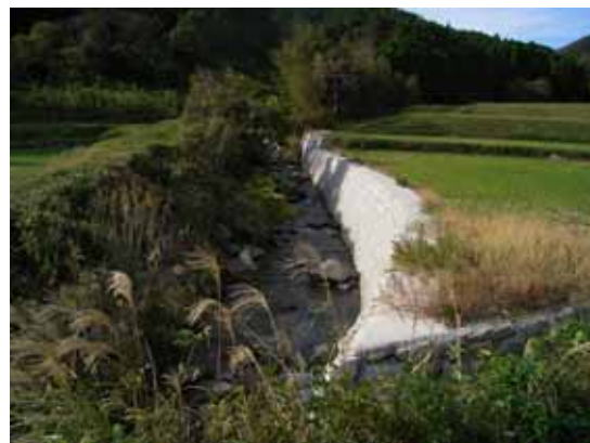
ワイヤーメッシュの未設置箇所（高さ 2.5 m のコンクリート護岸でイノシシの侵入が難しい）
