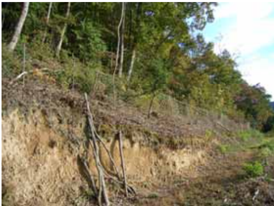
林縁部に設置されたシカ用ネット柵 （林縁部は約 2 m 幅に伐採後されている）
