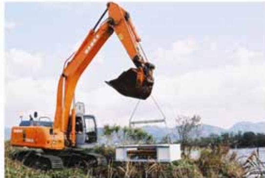
間伐材沈床の設置作業風景 (岡山県農林水産部水産課提供)
