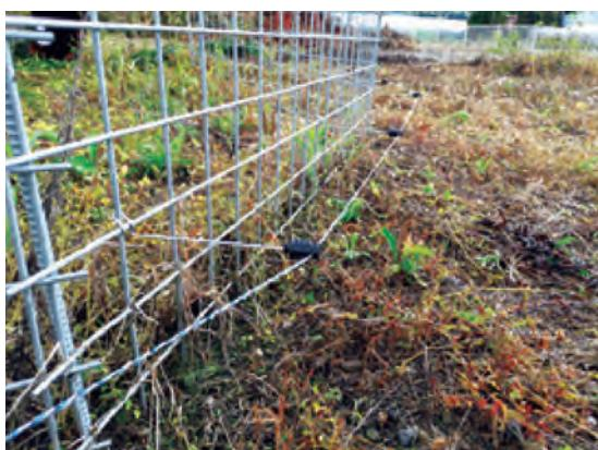
写真3-1-3 金属柵の下部に電気線を簡易に敷設できる碍子
