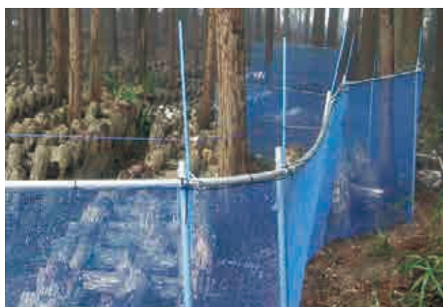
パイプを曲げて角部を処理した場合
