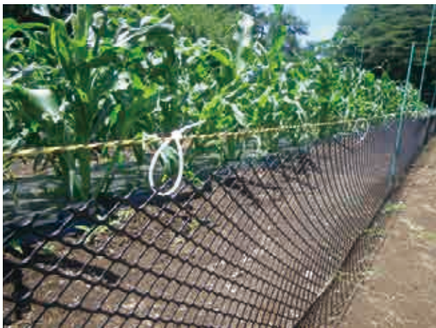
柵線とネットの間隔を5 cm以上に広げられないように結束バンドで固定
