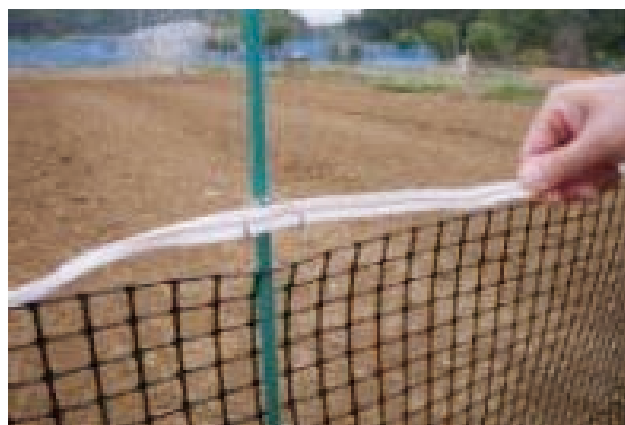
柵線を支柱にクリップで固定
