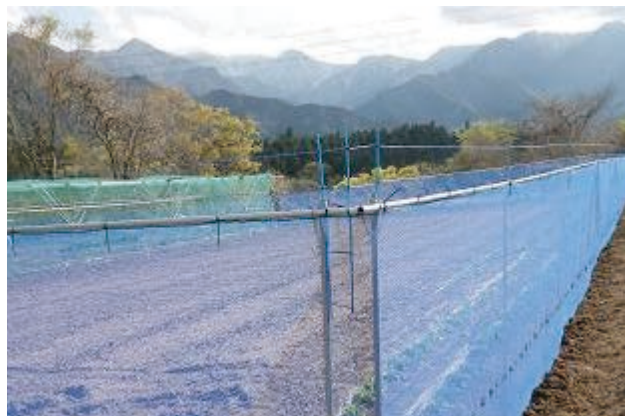
パイプを露出させながらネットとパイプを固定
