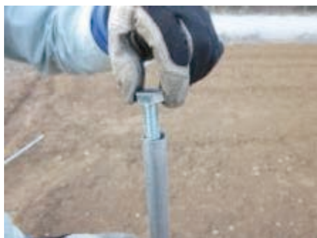
直管パイプにボルトをはめ込む
