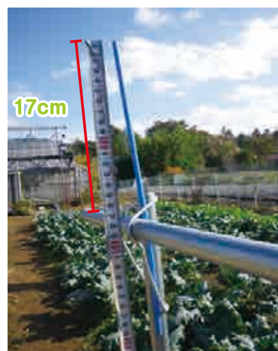
弾性ポールを横パイプの上部17cm程度出るように設置
