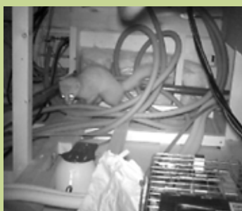
新築3年の民家に侵入し貯め糞などの糞尿被害に悩まされていたが、捕獲に成功。その後、大工さんによる点検のおかげで、侵入経路が特定。
