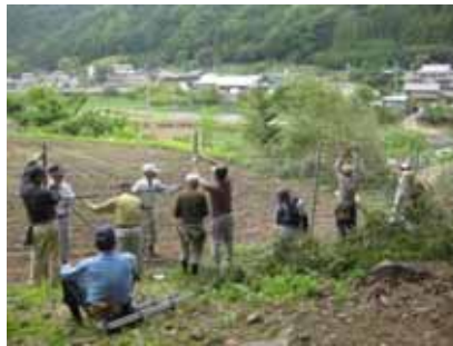
侵入防止柵の設置
