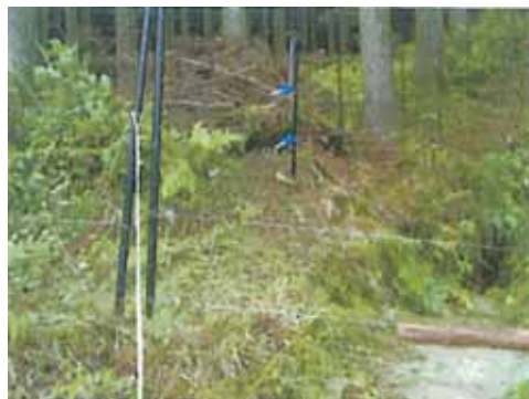
電気柵の設置
