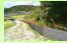
【広域的な防護柵の設置】
