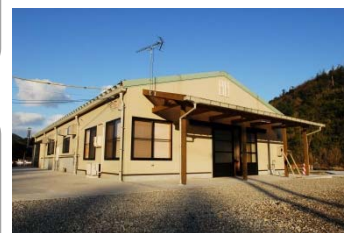
地元自治体が整備した加工施設を活用
