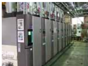
ボイラの更新
