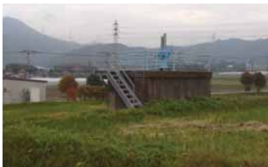
【 夜須支線水路八並分水工 】
