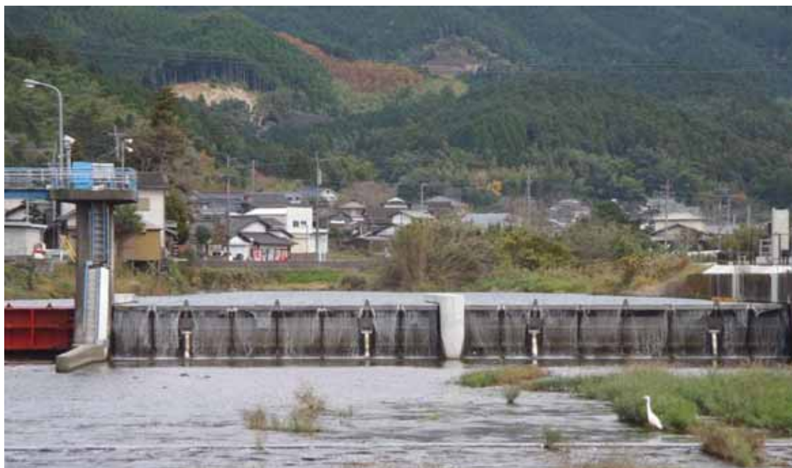
図 6-6 朝倉市歴史的景観条例に配慮した女男石頭首工のゲートの色彩
