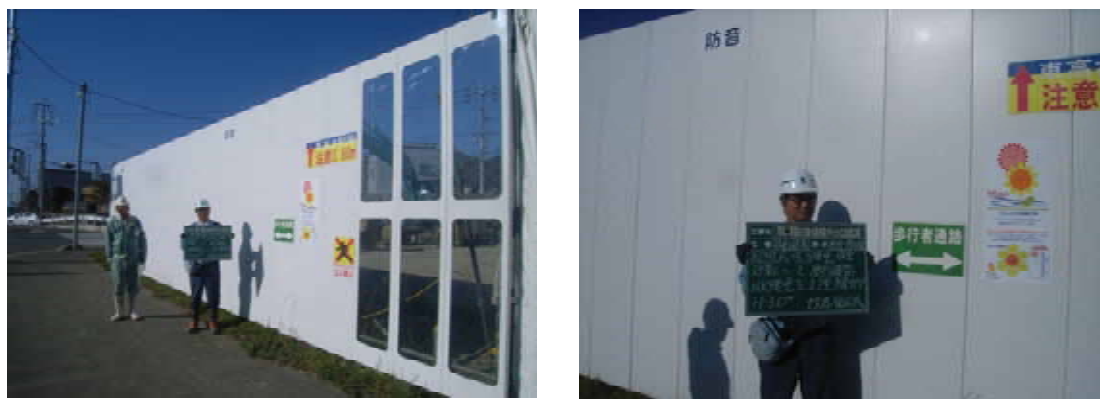
図 6-11 防音壁の設置（福田支線水路柿原 3 号分木工改築）
