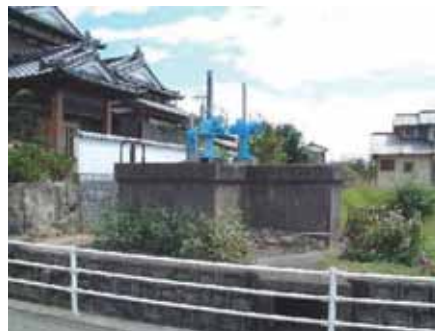
【 福田支線水路堤 2 号分水工 】
