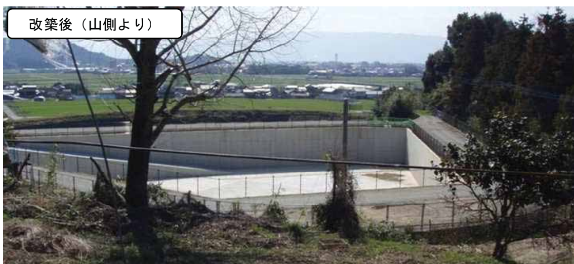
図 6-7 農村景観に配慮した弥永調整水槽
