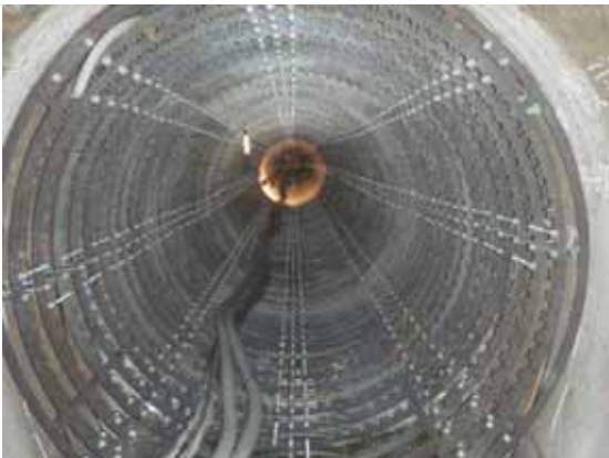
図 7-1 トンネル内巻補強工法の施工状況
