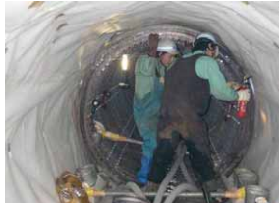
〔 トンネル内巻補強工法完成状況 〕
