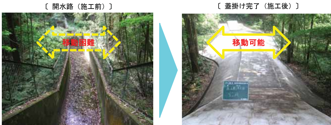
図 6-5 生物の移動に配慮した開水路の施工
