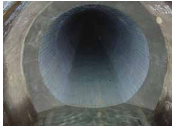
図 7-1 トンネル内巻補強工法の施工状況
