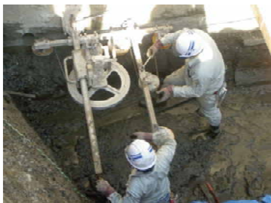
【 ワイヤーソーイング工法 】
