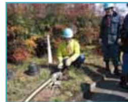
給水栓にアタッチメントを取付けての給水
