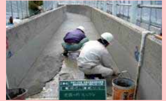
ポリアセトモルタルによる補修
