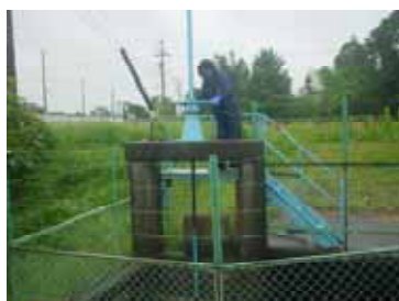
施設管理人による配水・分水操作
