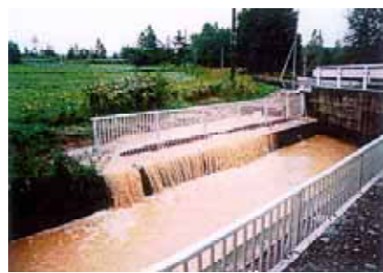
地域の排水を受け入れる農業用水路
