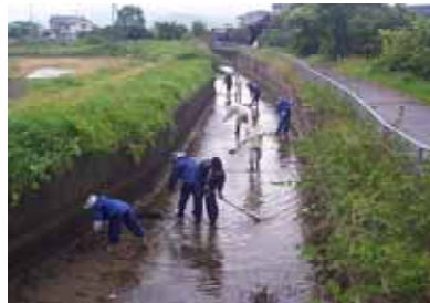
水管理組合による水路の浚渫
