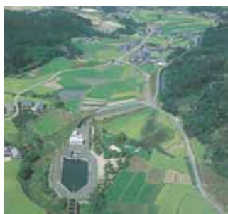
農業用水を分配する水利施設
