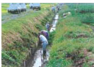
用水路の泥上げ
