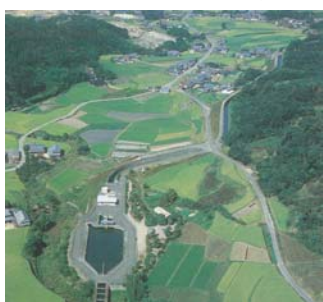
農業用水を分配する水利施設
