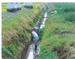
水路の泥上げ
