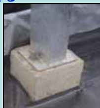
ソイルセメントを用いた基礎部の補強
