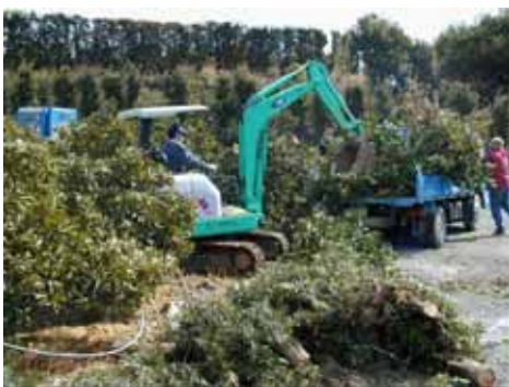
園内道設置作業
