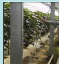
ブレースの増設
