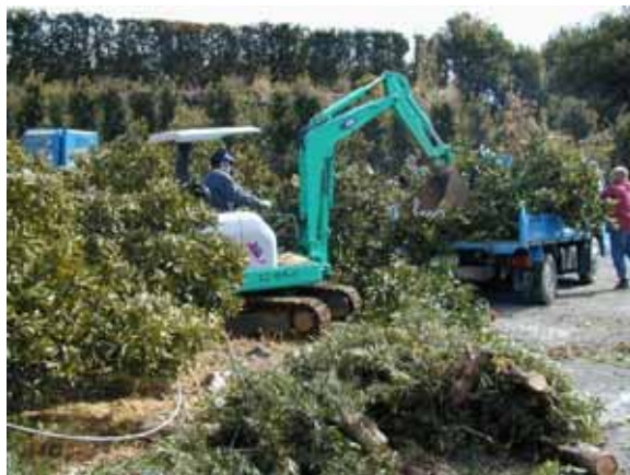
園内道設置作業
