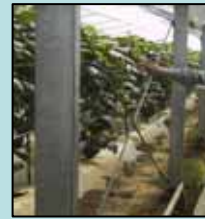
ブレースの増設
