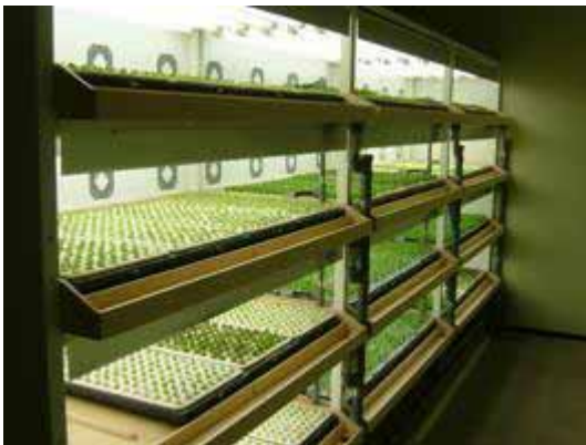
閉鎖型苗生産施設(内部写真)
