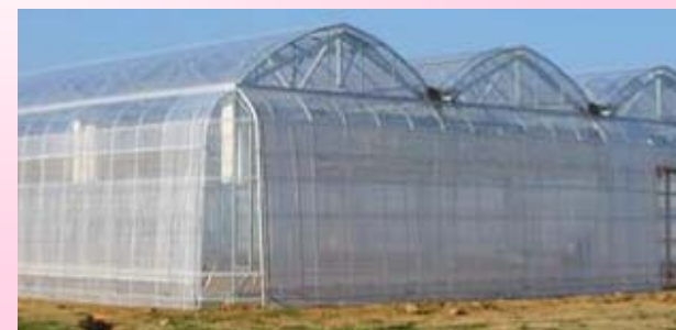
↑ 超低コスト耐候性ハウスの外観
