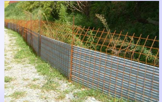
↑「忍び返し」の施工例(滋賀県日野町)
