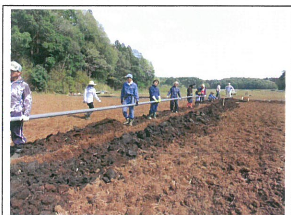
給水管の埋設は全員で作業に取り組む
