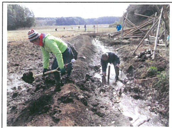
水路掘りはぬかるみ、体力も消耗する
