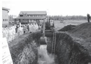
大型重機を使用した埋却の実演
