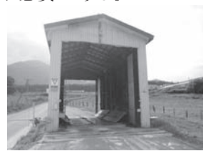
大型肉牛農場の車両消毒装置（清水町）
