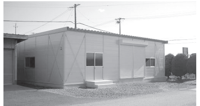
本所に増設された備蓄倉庫
