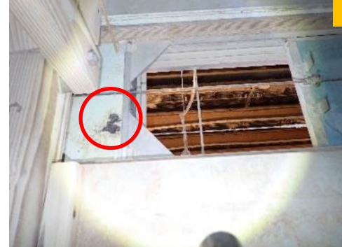
鶏舎側面の入り口木板の破損と天井裏の中型哺乳動物のものと思われる糞
