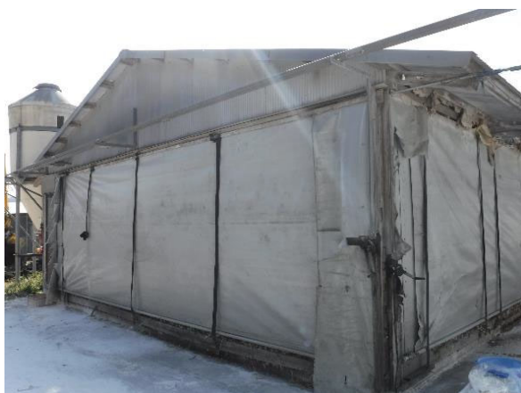
<発生家きん舎外観>
