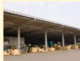
VFステーション
