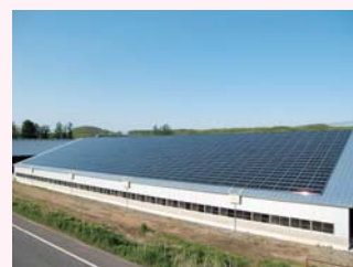
太陽光パネルが設置された牛舎
