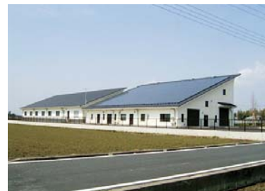
たい肥施設の屋根に設置した太陽光パネル（千葉県山武市）
