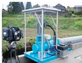
小型小水力発電機の実証試験の様子（大分県竹田市）
