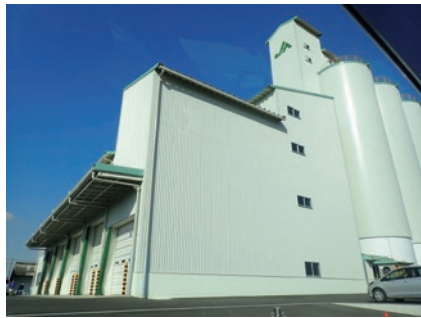
復旧を終えたカントリーエレベーター （熊本県嘉島町）
