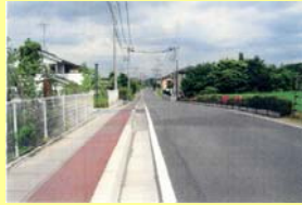
学童通学路の歩道側溝が整備された集落道路
