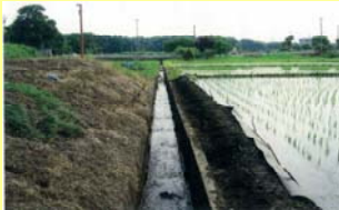
排水不良が解消された農業用排水路
