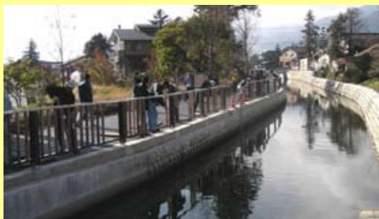
木柵設置の協働作業
